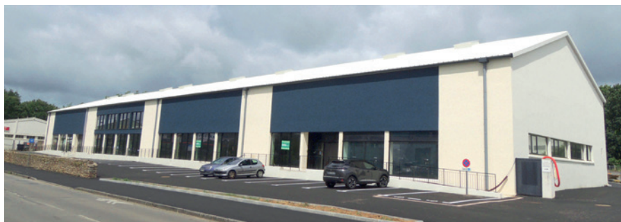
Locaux d'activité réhabilités (2 000 m 2 ) dans la zone de Kergonan Sud (Brest)
