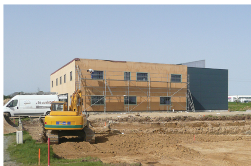
Locaux d'activité à Guipavas (zone de Prat Pip) Photo : ADEUPa
