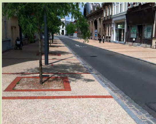
Requalification de la rue de la gare en voie bus et liaison piétonne avec le centre-ville © Cerema/DTer Nord-Picardie
