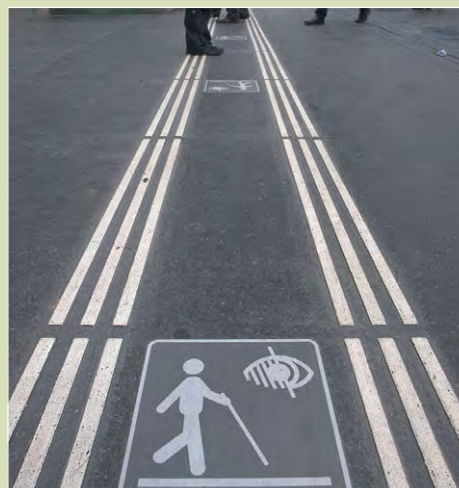
Signalétique accessibilité, bande podotactile © Bernard Suard/MEDDE-MLETR
